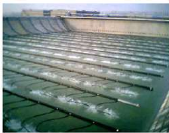
悬挂链、可提升微孔曝气
