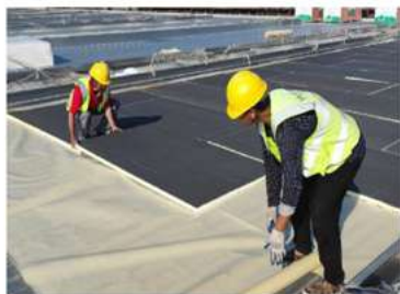
铺设PIR保温板
