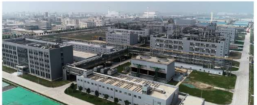
山东国邦805厂区全景-山东潍坊
